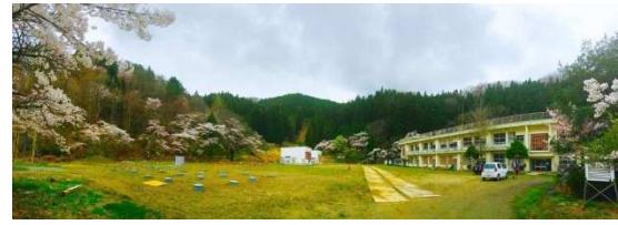
旧郡山市立赤津小学校を活用した、郡山市と日本大学工学部の再生可能エネルギー共同研究施設
