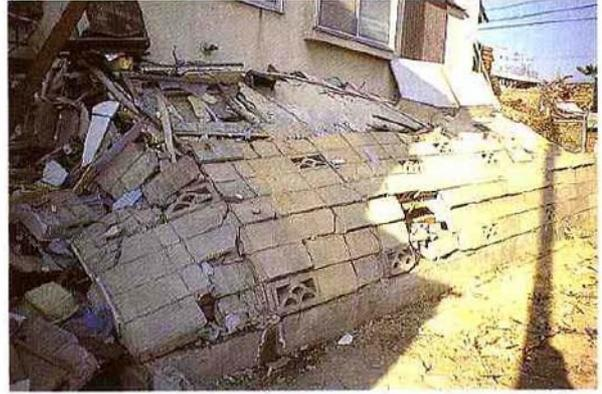
写真のようなブロック塀の倒壊が数多くみられた。以前から指摘されたとおり大きな凶器だ。
