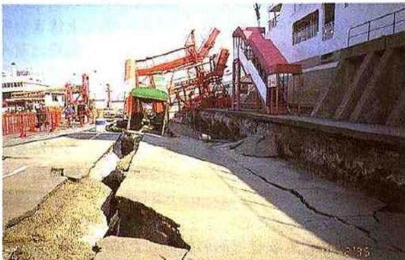
フェリーボート用栈橋が、液状化現象による陥没のため傾斜し使用不能となった。
