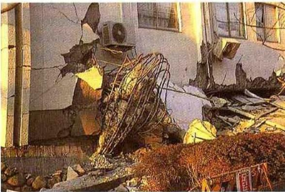
鉄筋コンクリート造4階建の家屋の1階部分での破壊状況（東灘区）
